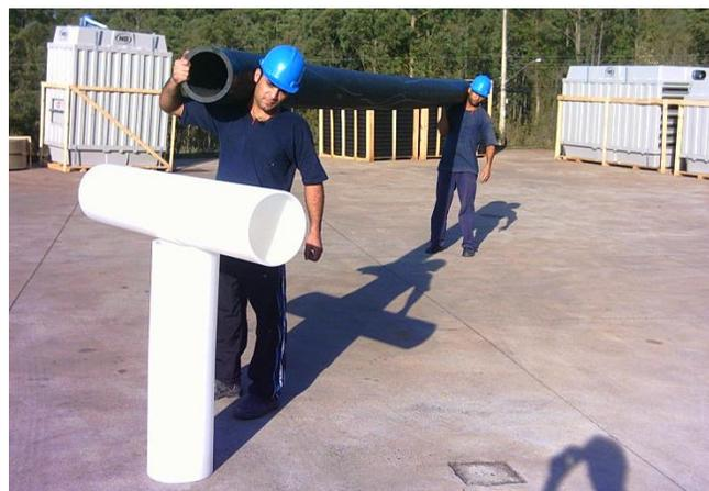
Os tubos de PE possuem um coeficiente de resistência à abrasão aproximadamente 5 vezes superior ao do aço e até 20 vezes maior que o concreto.
