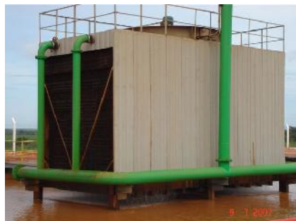
Torre com enchimento tipo grade GRT em operação; GRT type fill cooling tower in operation.
