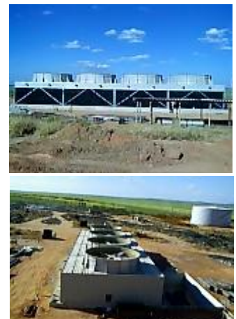
Torre de 4.000m3/h em operação; 17,600GPM cooling tower in operation.
